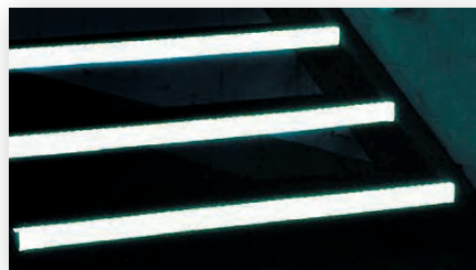
Markierung von Treppenhäusern
